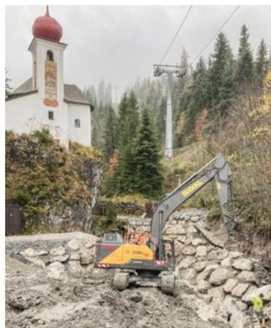
Baumaßnahmen im Jahr 2023. Insgesamt wurden 2.500 m<sup>3</sup> Beton, 150 Tonnen Baustahl und 1.500 Tonnen Wasserbausteine verarbeitet. Diese beeindruckenden Zahlen unterstreichen das Ausmaß der Bauleistungen und die Notwendigkeit einer solch umfassenden Sicherungsmaßnahme.
