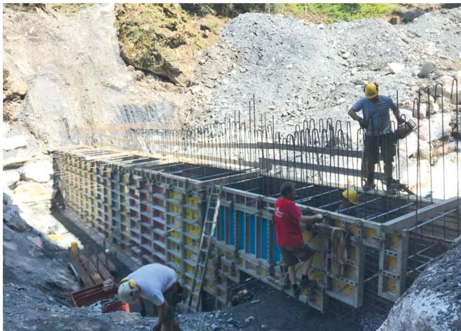
Das Bild zeigt die Errichtung einer sogenannten „Vorsperre“. Im Anschluss, also flussaufwärts, wird dann das 15 Meter hohe und 58 Meter breite Geschieberückhaltebecken errichtet. Diese Vorsperre soll ein Ausspülen des Fundamentes des Hauptbauwerkes verhindern.
