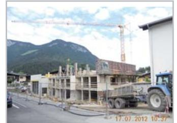
montiert, die Trockenbauwände in allen Geschossen hergestellt und die Verputzarbeiten fertig gestellt. Die Rohinstallationsarbeiten für Elektro sowie Heizung-Sanitär und Lüftung sind ebenso wie die Herstellung der Fußbodenaufbauten, der Fassaden und Außenanlagen voll im Gange.
