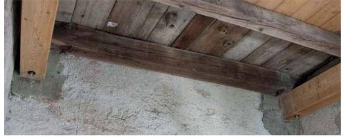
Die Holzkonstruktion des Glockenstuhles steht frei im Kirchturm und ist am unteren Ende an den vier Ecken im Mauerwerk des Kirchturmes verankert. Vom Schnee am Kirchendach ist über Jahrzehnte Feuchtigkeit zu einem ins Mauerwerk stehenden Holzbalken gelangt, sodass dieser ganz langsam zurückfaulte, bis er schließlich keinen Kontakt mehr zur Mauer hatte und der Glockenstuhl nur mehr an drei Ecken verankert war.
